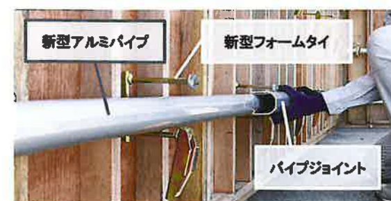
施工方法の簡素化により、誰でも簡単・確実に締め付け可能
