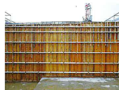
アルミ製パイプ1本による締め付けを可能とした
